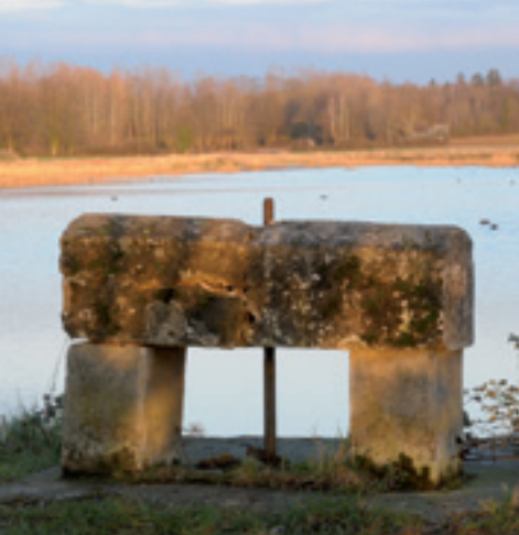
L'étang du Grand Moulin à Civrieux.
