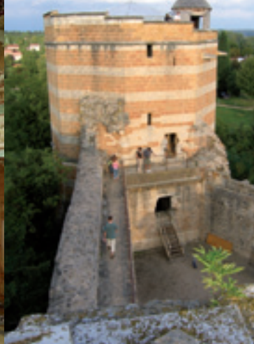
Le donjon octogonal du château fort de Trévoux domine la ville depuis plus de six siècles.
