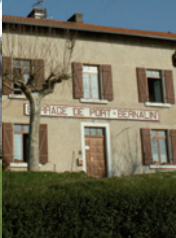
La maison éclusière de Port Bernalin, à Parcieux, liée au barrage à aiguilles mis en service en 1879.
